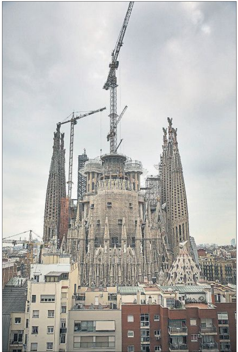
Estado de las obras de construcción de las torres vistas desde la calle Rosselló
